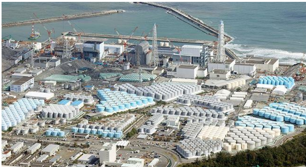
Des centaines de réservoirs, qui contiennent de l'eau radioactive, s'entassent dans la centrale de Fukushima
